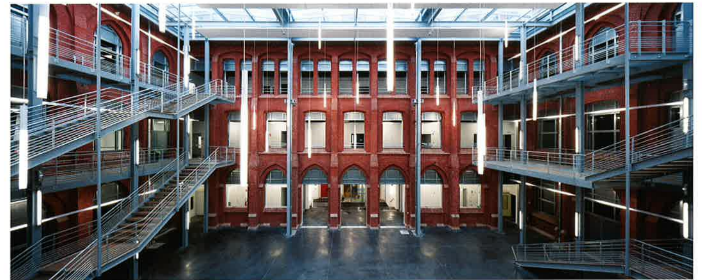
Deux niveaux de coursives sont rapportés sur les façades de l'atrium.
