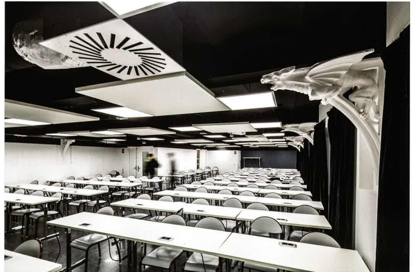
La charpente métallique et ses appuis en forme de tête de dragon.
