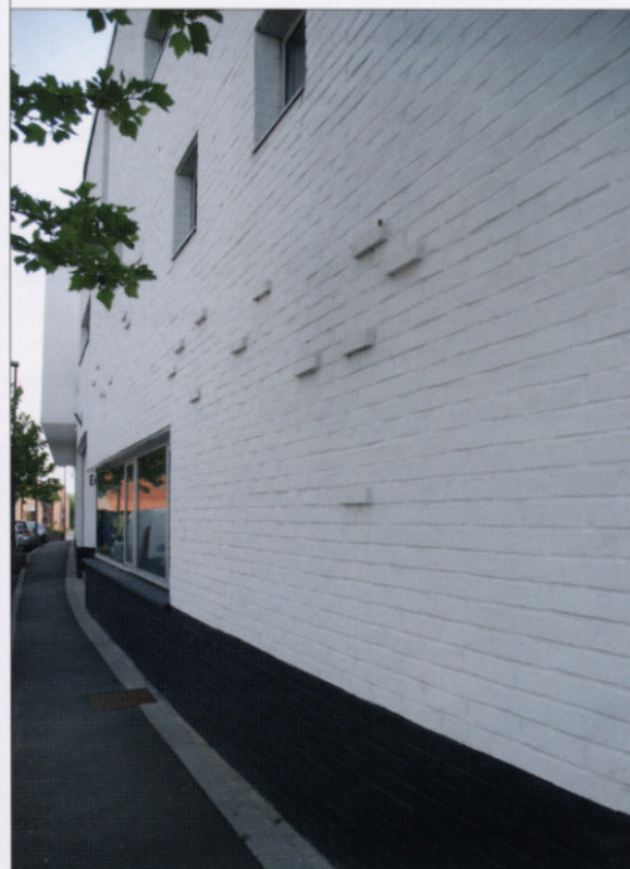
▼ La façade nord se cintre pour épouser la rue Norbert Segard. La brique peinte en blanc (et noir en soubassement) fait un clin d'œil à l'architecture campagnarde flamande.
