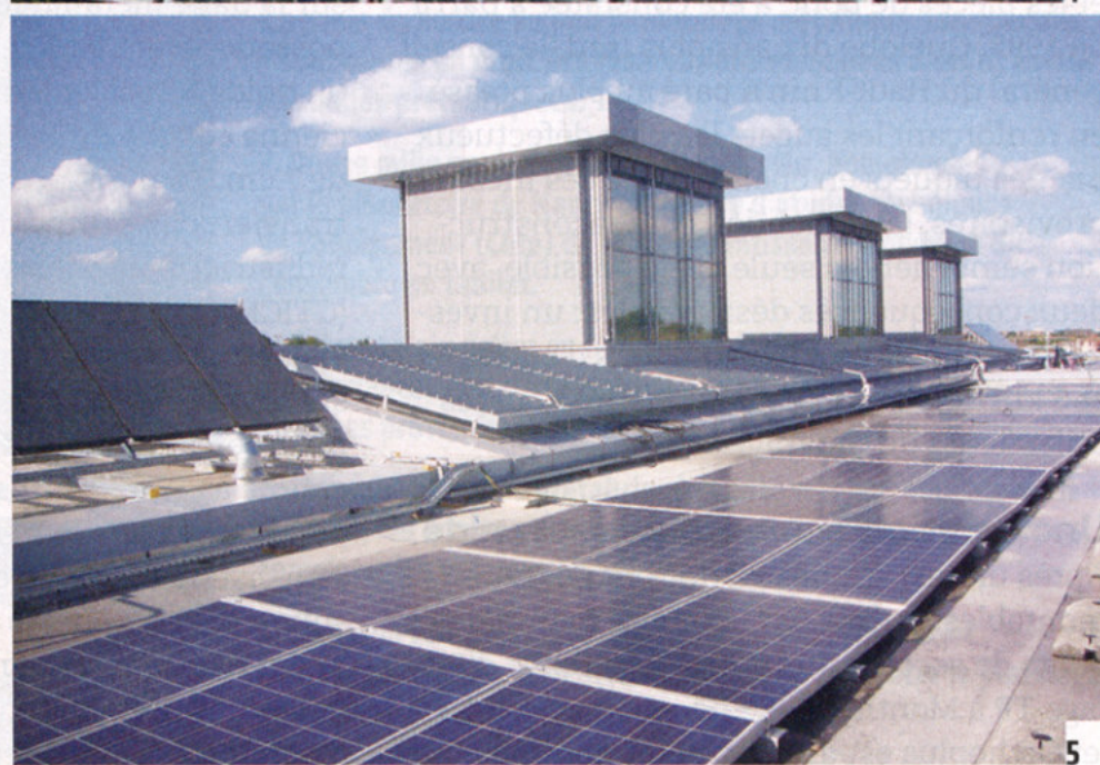
PHOTOS : BLAQ ARCHITECTURES
