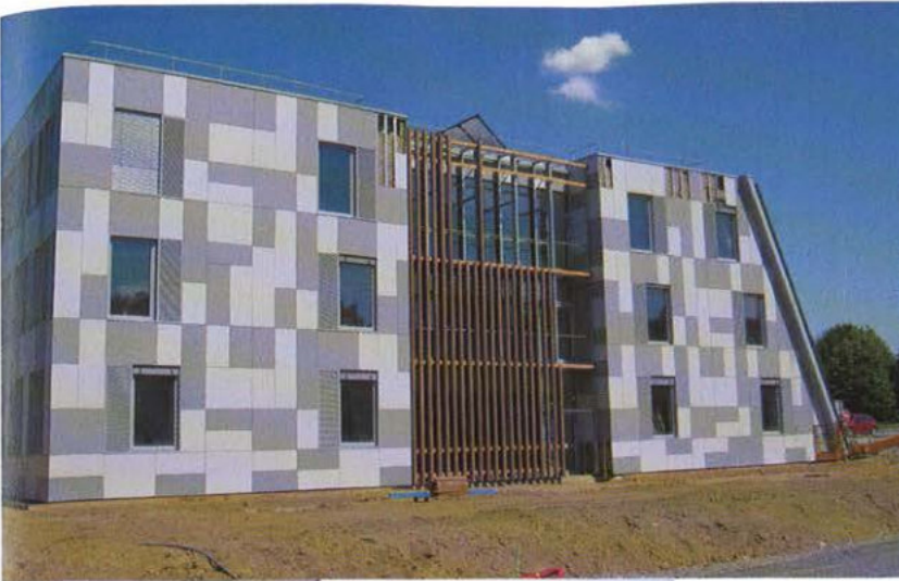
L'un des deux bâtiments neufs : Kitchen, avec sa façade rideau inclinée qui a à la fois une fonction solaire passive (vitrage) et une fonction solaire active (capteurs photovoltaïques).
