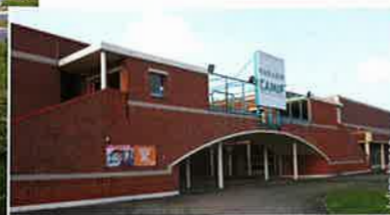
Bâtiment avant travaux.
