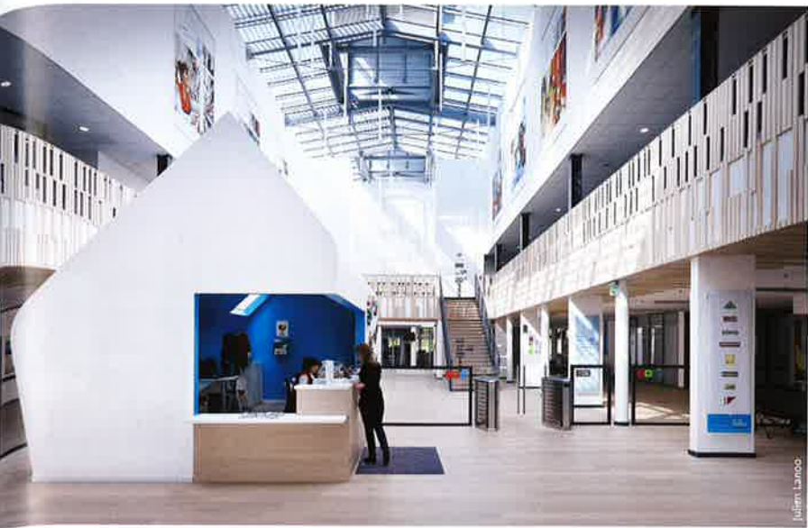
Hall d'accueil couvert par une verrière munie de cheminées de ventilation.
